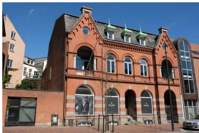
Jernbanegade 29, tidligere nationalbankfilial
