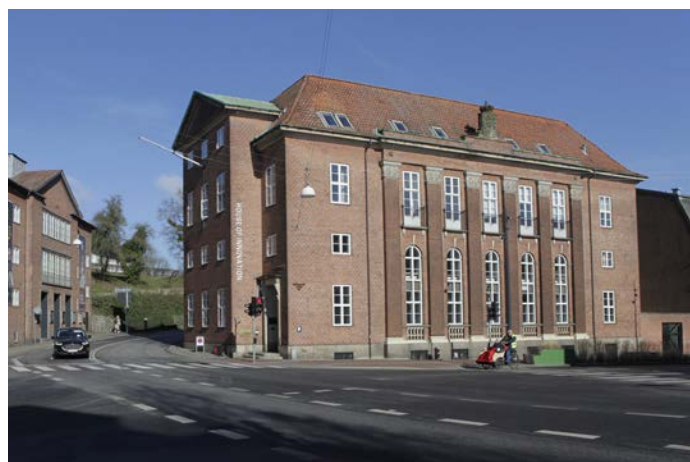
Tidligere nationalbankfilial på hjørnet af Jernbanegade og Fredericiagade
